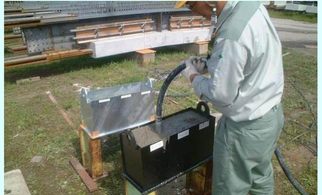
コンクリート打設・バイブレータ挿入状況
