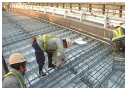
場所打ちタイプによる床版取替え
