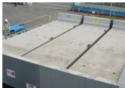
プレキャストタイプによる床版取替え
